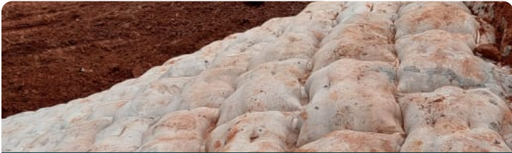
刚充填完成的 AB400 联锁垫表面质感
