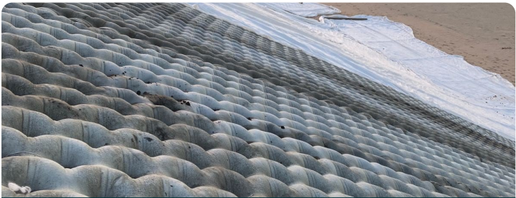
黄昏沙漠中完工的 FP400 联锁垫
