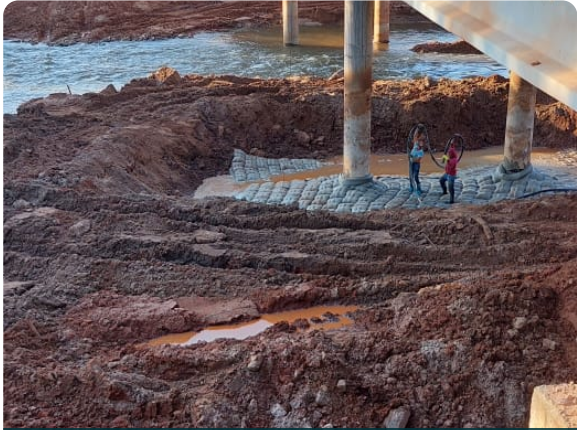
桥墩防护——采用同一系统施作
