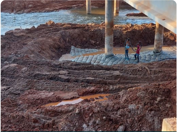
桥墩防护——采用同一系统施作
