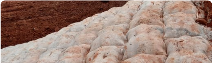
刚充填完成的 AB400 连锁垫表面质感
