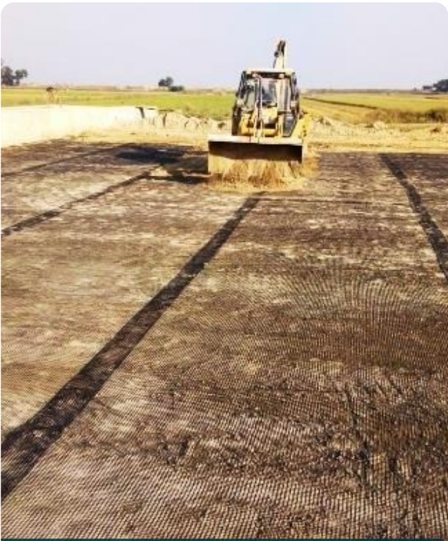
骨料直接摊铺在土工格栅上：从第一遍碾压起就开始约束 · 图片：Strata
