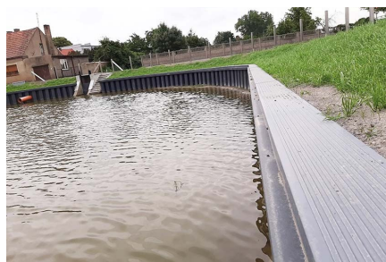
城市渠化工程，冠梁之上设步行道
