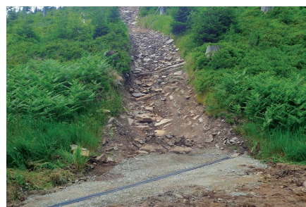
道路排水：不被冲刷的衬砌渠道
