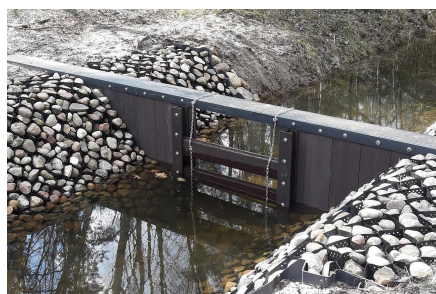
水工程：溢洪道、闸门与拦水坝
