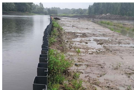
岸坡防护：阻止岸脚的淘刷
