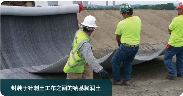
铺开、搭接、覆盖：无需焊接
