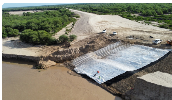
Estendimento da fôrma têxtil antes do preenchimento
