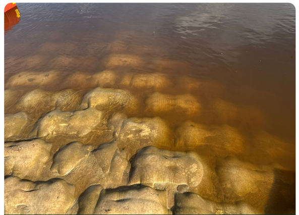
Colchão cheio sob a água, em serviço
