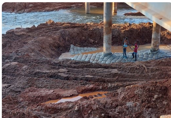
Proteção de pilares da ponte — executada com o mesmo sistema
