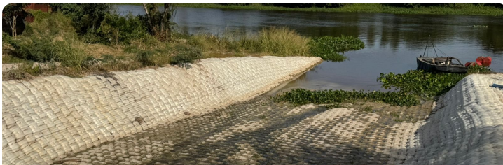
O canal de descarga protegido, em serviço
