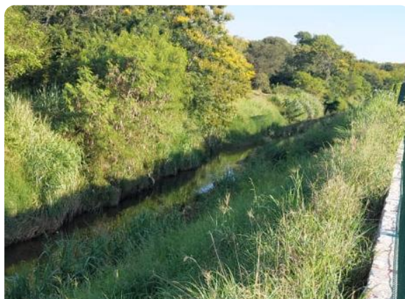
O mesmo trecho, completamente revegetado
