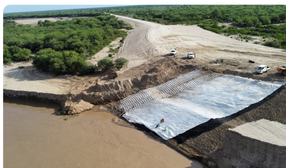
Estendimento da fôrma têxtil antes do preenchimento
