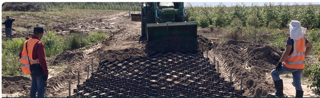
Estrada florestal reforçada com StrataWeb® de 100 mm dentro da plantação: a célula é preenchida com o material do próprio local — Concepción
