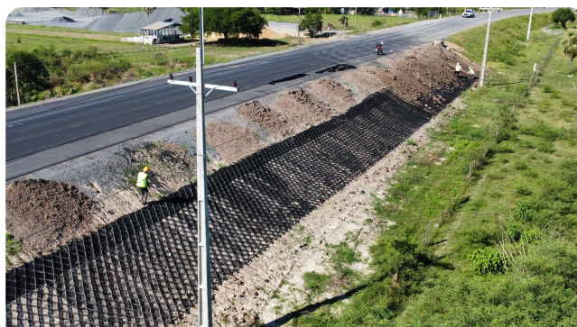
57.000 m 2 de talude revestido com StrataWeb® — acessos a Alberdi
