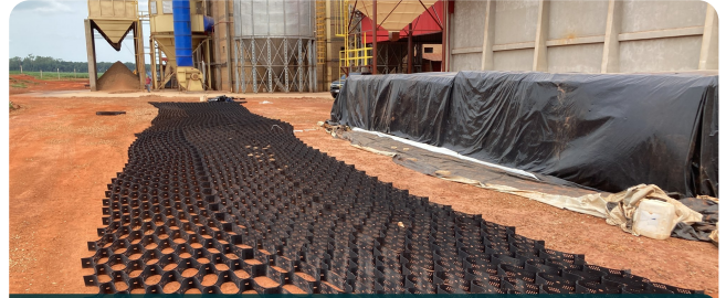
StrataWeb® desdobrada sobre a estrada, antes do preenchimento
