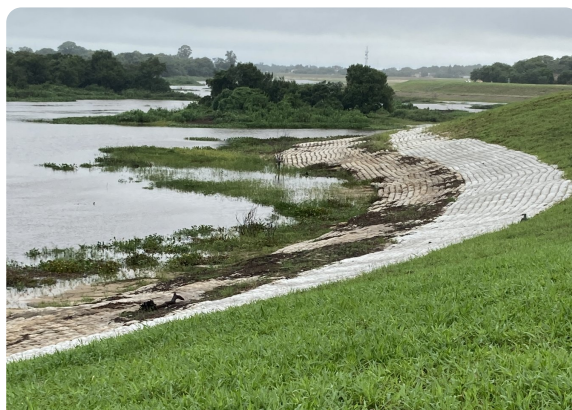
Vegetação estabelecida — o canal funcionando com a grama já madura
