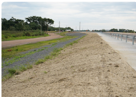
Manto hidráulico recém-aplicado — proteção desde o primeiro dia
