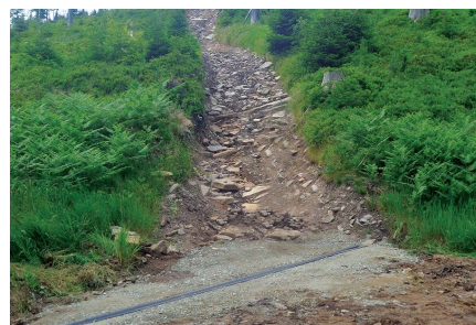
Drenagem viária: canal revestido que não se erode
