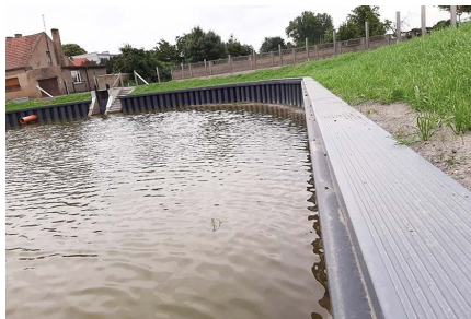
Canalização urbana com passeio de pedestres sobre a coroação
