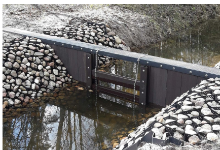
Obras hidráulicas: vertedouros, comportas e açudes
