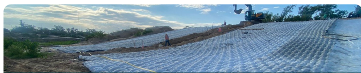
La obra en ejecución sobre la margen del río Paraguay
