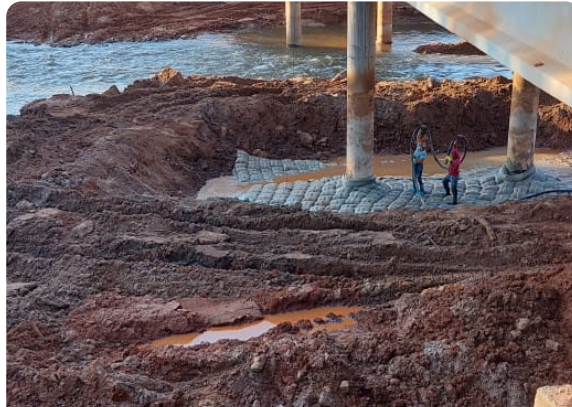
Protección de pilas del puente — ejecutada con el mismo sistema
