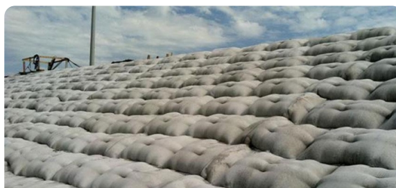
Detalle del sistema de revestimiento articulado
