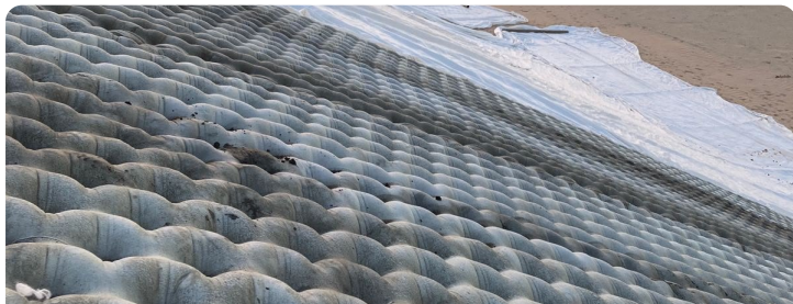
El colchón FP400 terminado, al atardecer sobre el desierto
