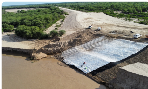
Extendido del encofrado textil antes del llenado
