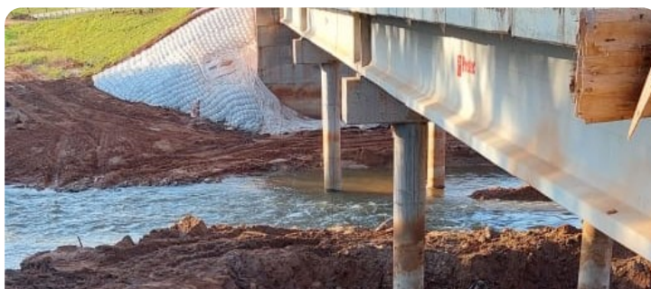
Bloque Articulado protegiendo el estribo y las pilas – Puente Arroyo Gasory, Paraguay
