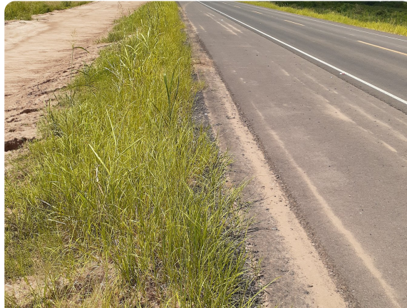
Talud vegetado junto a la calzada – el resultado
