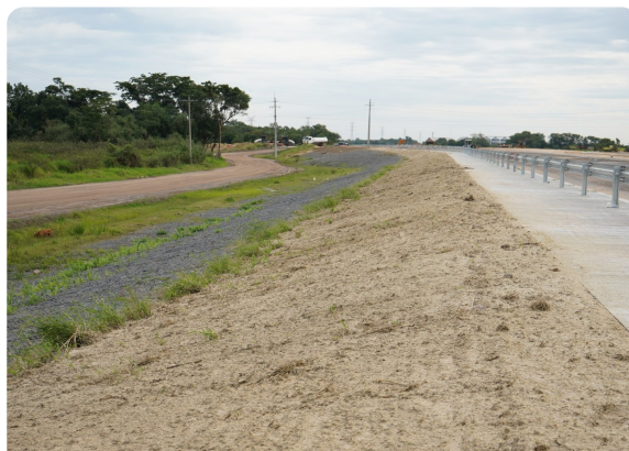
Manto hidráulico recién aplicado — protección desde el día uno
