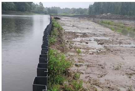
Defensa de margen: frena la socavación del pie de barranca
