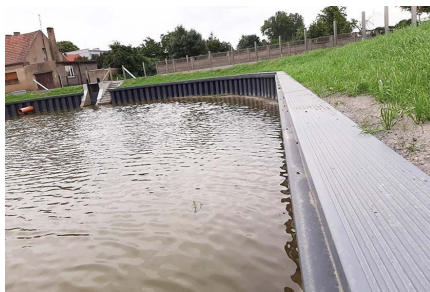
Canalización urbana con paseo peatonal sobre la coronación
