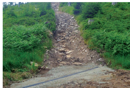
Drenaje vial: canal revestido que no se erosiona
