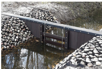
Obras hidráulicas: vertederos, compuertas y azudes
