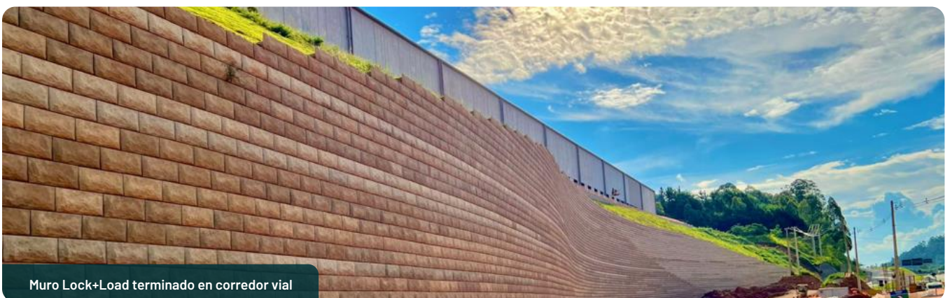
El sistema completo: módulo Lock+Load, geogrilla StrataGrid™, geotextil de separación, geocompuesto StrataDrain™ y dren de pie
