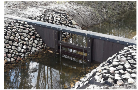
الأعمال الهيدروليكية: المفيضات والبوابات والسدود المنخفضة
