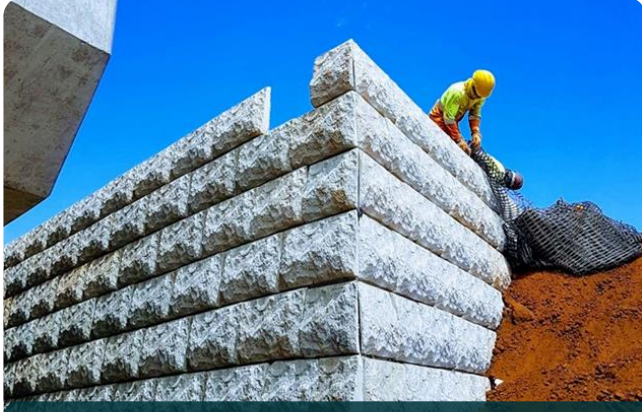
الوحدة المكسدة والشبكة التي تثبتها بالكتلة — جدار Lock+Load قيد الإنشاء
